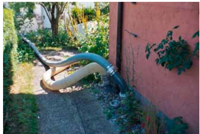
Für die Pelletlieferung sind zwei normierte Öffnungen nötig.
