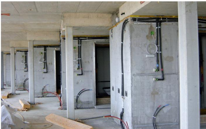
**Paraplegikerzentrum Nottwil, Ausschnitt mit vier Massivbau-Fertigbadzellen. Bauzustand nach Betonieren der darüber liegenden Decke, vor Einbau der angrenzenden Zimmerwände.**
