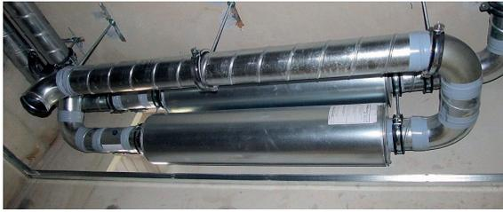
**Montage im Werk: Lüftungsinstallation mit Schalldämpfern in runtergehängter Decke.**
