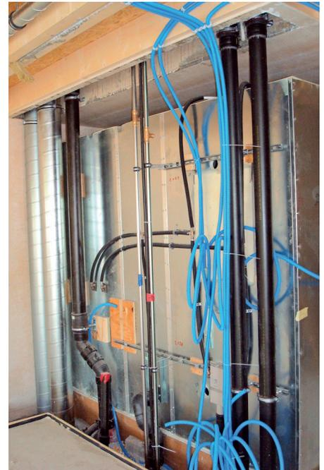
**Strangmontage an der Rückseite eines Leichtbau-Fertigbads: Lüftung, Abwasser, Trinkwasser, Elektro.**
